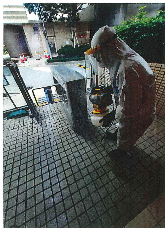
11. 6號及7號貨用升降機大堂(平台)
