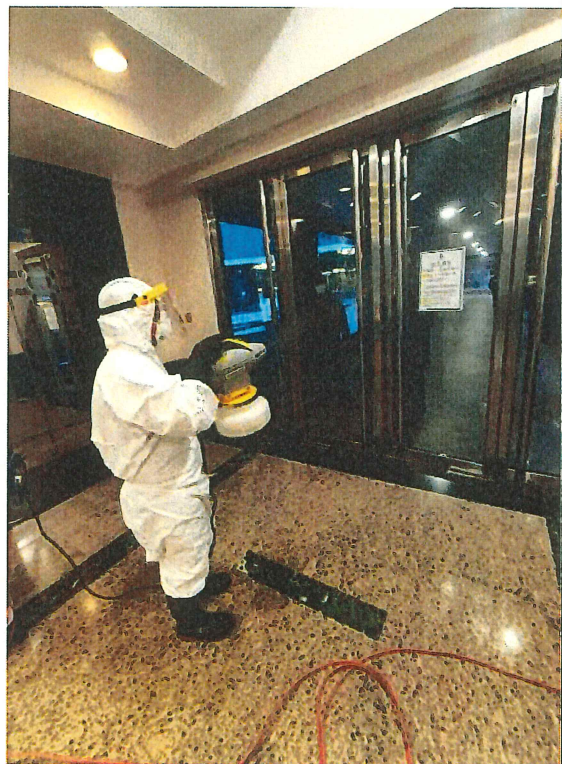
8. 穿梭升降機大堂(平台)
