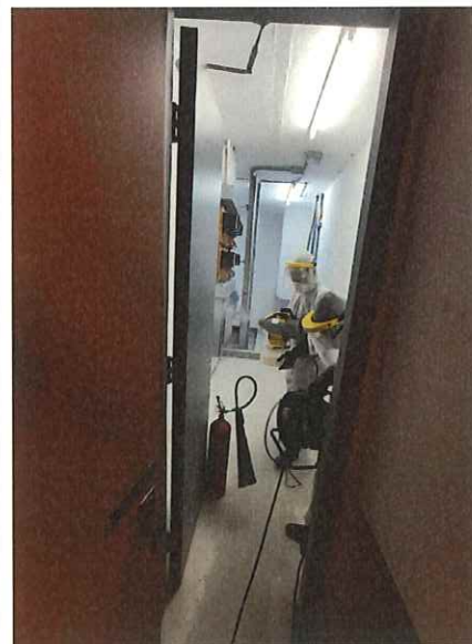
8. 第5座相關樓層設施房
